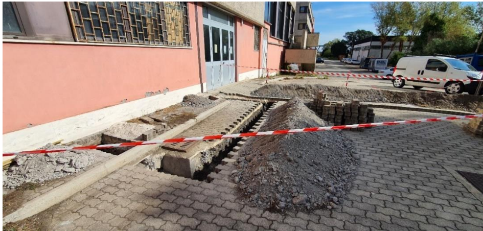
Figura 2: Lavori in corso per la realizzazione dello scavo necessario al posizionamento delle tubazioni di collegamento termico dell'impianto S.A.P.I.E.N.T.E. al montante termico 1 dell'edificio F-83.
