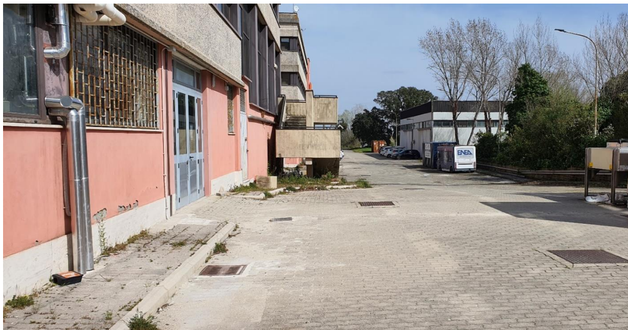
Figura 4: Ripristino dello stato esterno dei luoghi oggetto dello scavo all'interno del quale è stato realizzato il posizionamento delle tubature atte al collegamento termico dell'impianto S.A.P.I.EN.T.E. con una delle colonne montanti dell'edificio F-83.
