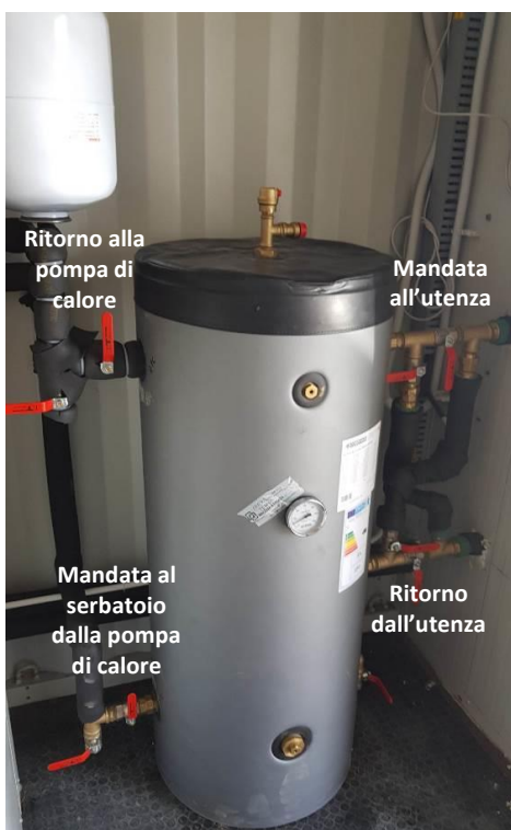
Figura 97. Collegamento del volano termico alla pompa di calore e all'utenza
