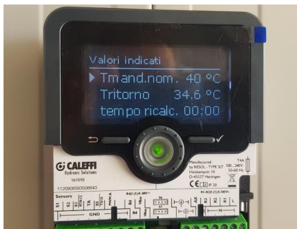
Figura 89. Centralina per il controllo della valvola miscelatrice
