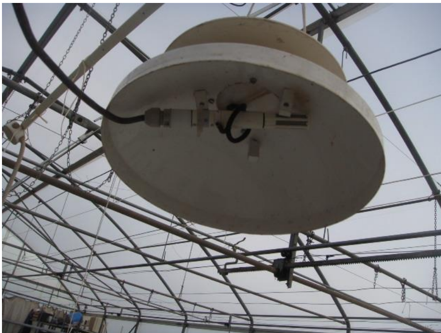
Figura 27. Sensori: Termistore per la misura della temperatura e dell'umidità relativa dell'aria all'interno della serra.
