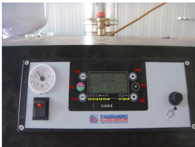
Figura 8. Consolle e pulsantiera di comando della caldaia a biomassa CS30 presso l'Università di Bari.
