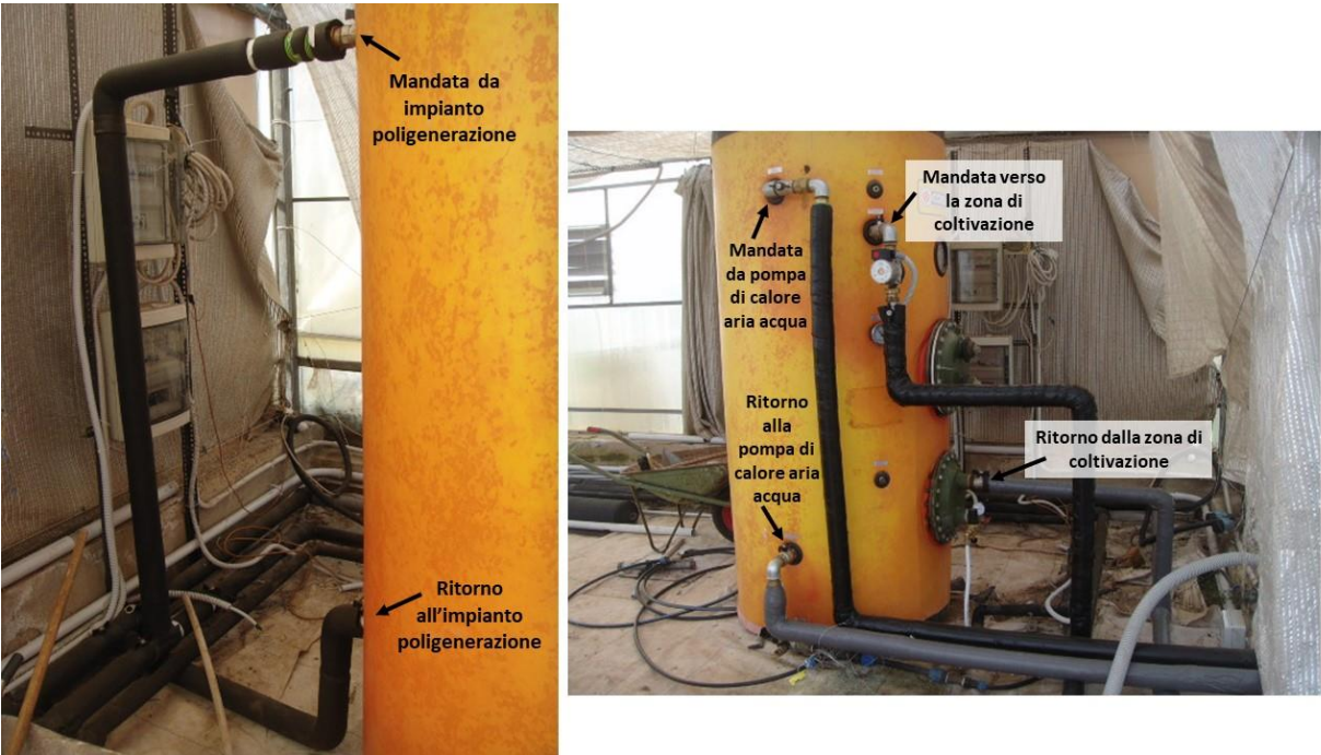
Figura 18: Serbatoio ausiliario all'interno della serra e tubazioni di mandata e ritorno dell'acqua fredda/calda.
