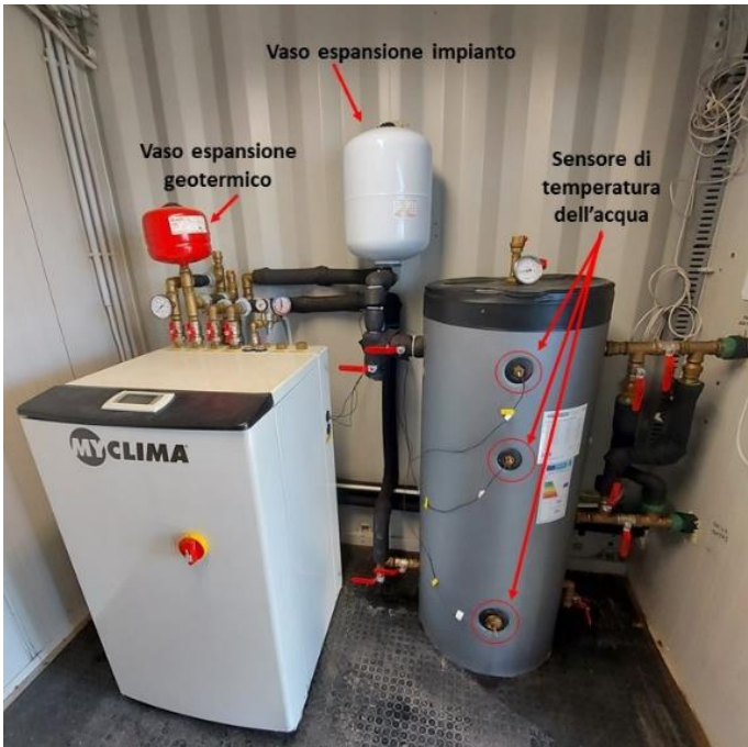
Figura 10. Sensori per la misura a diverse altezze della temperatura dell’acqua presente all’interno del serbatoio.
