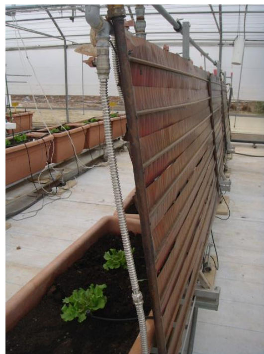
Figura 24. Sistema di distribuzione del freddo/caldo denominato “piastre”.
