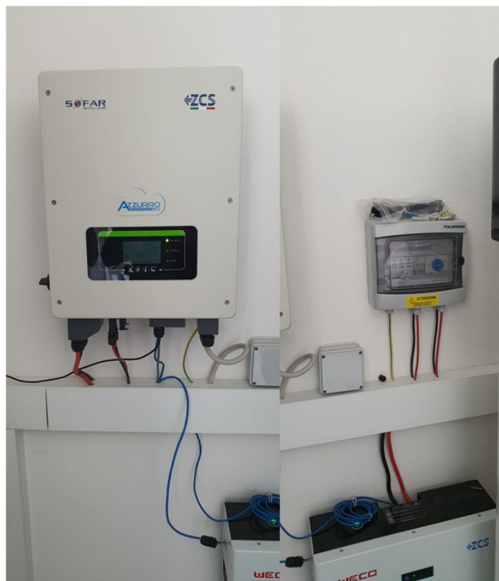
Figura 104: installazione in cabina dell'inverter ibrido da 3 kW, del sistema di accumulo a litio da 4,5 kWh e del quadro di sezionamento stringa
