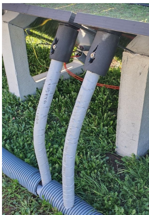
Figura 99: dettaglio connessione idraulica moduli PVT al circuito principale di mandata e ritorno dall'accumulo della pompa di calore
