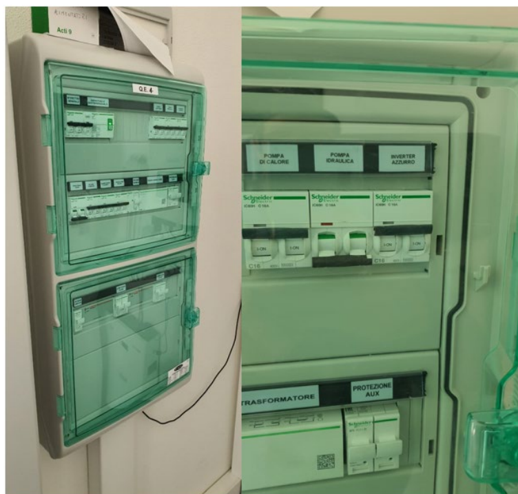
Figura 105: Installazione quadro elettrico generale dell'impianto sperimentale
