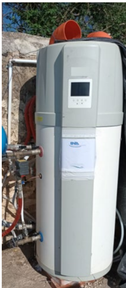
Figura 129: pompa di calore monoblocco per acqua calda sanitaria connessa al cogeneratore dell'impianto sperimentale
