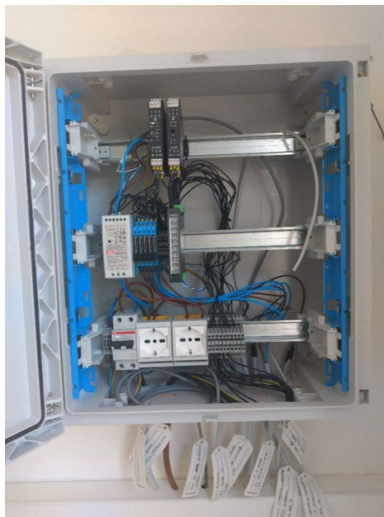
Figura 106: Quadro di comunicazione installato in cabina 3 e contenente i moduli I/O per il controllo dei componenti d'impianto con il PLC.
