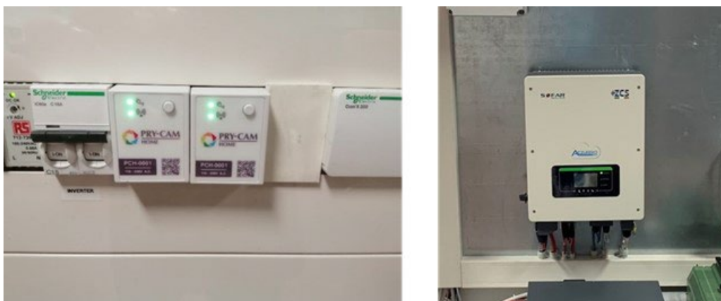
Figura 61. Sistema di monitoraggio del dimostratore: smart meter (sinistra) ed inverter (destra).
