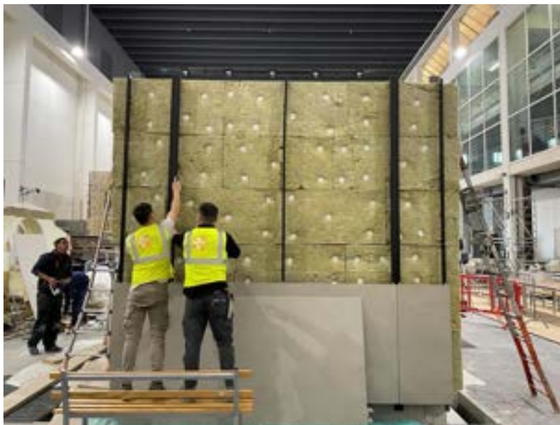
Figura 253. Parete ovest: posa dell'isolante e installazione delle lastre ceramiche di rivestimento
