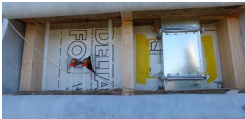
Figura 31. Progetto BERTIM – Installazione dei moduli in facciata
