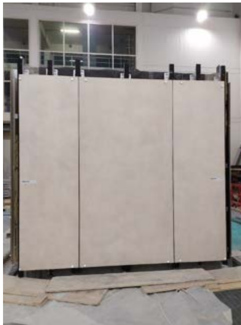
Figura 270. Parete nord: vista della parete finita
