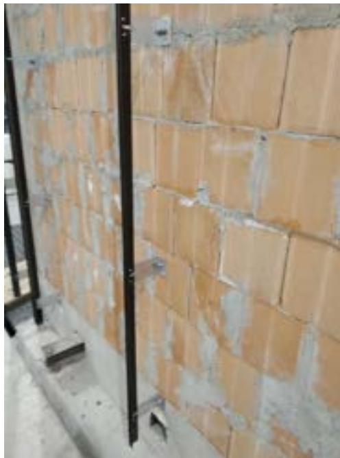
Figura 252. Parete ovest: ancoraggio dei profili metallici verticali
