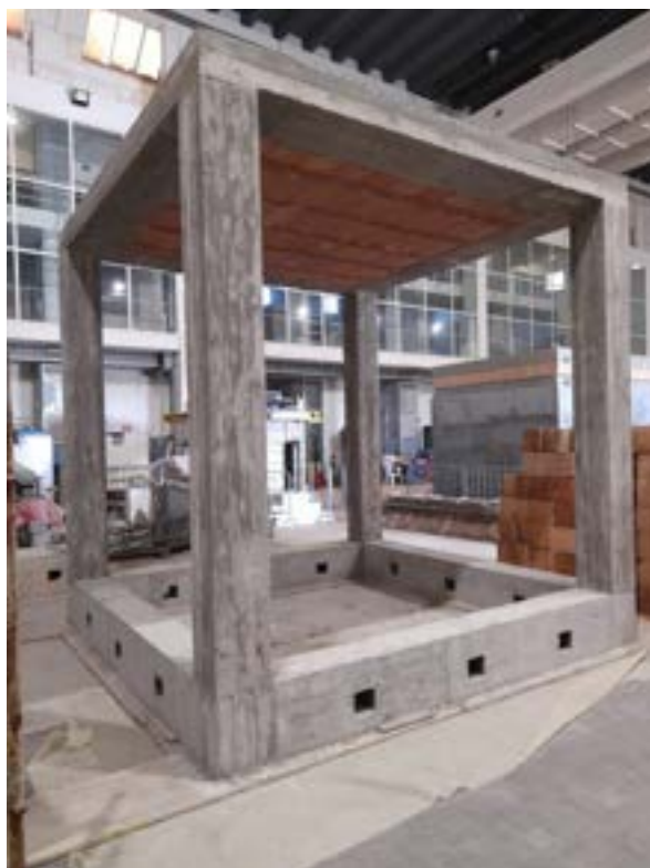
Figura 242. Manufatto in cemento armato
