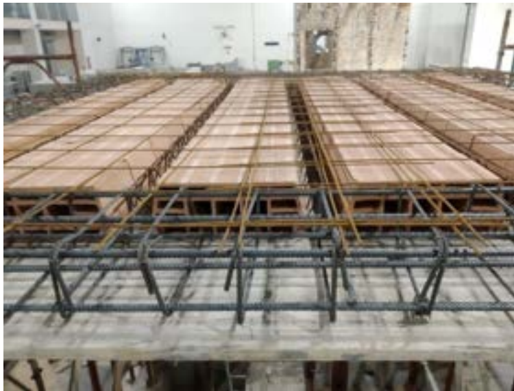
Figura 240. Realizzazione dei pilastri e del solaio: vista delle armature del solaio
