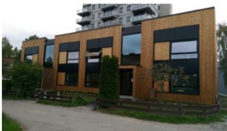
Figura 37. Progetto 4RinEU – Edificio dimostrativo a Oslo
