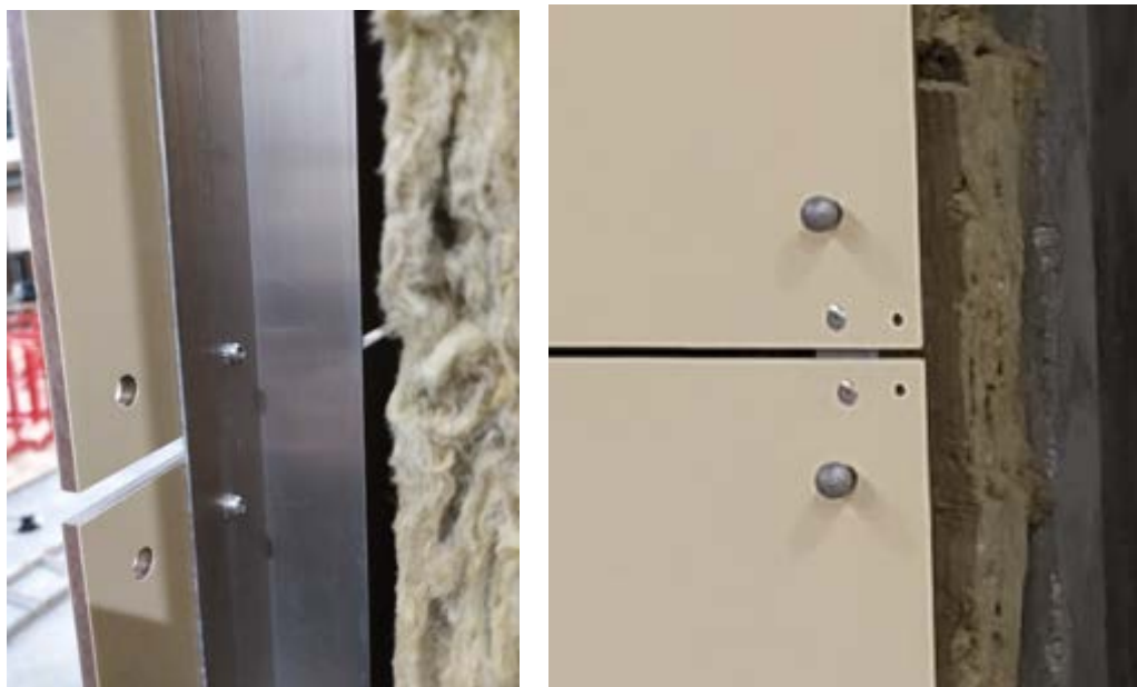
Figura 260. Parete est: installazione dei pannelli in HPL
