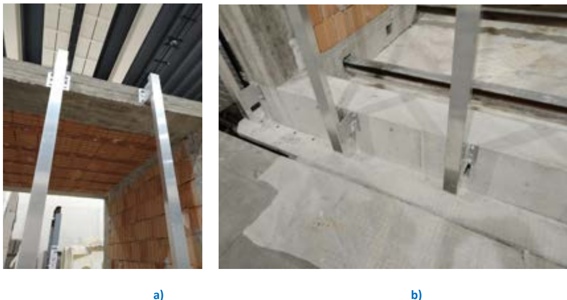
Figura 266. Parete nord: installazione dei profili verticali (a) e vista di dettaglio dei loro ancoraggi (b)
