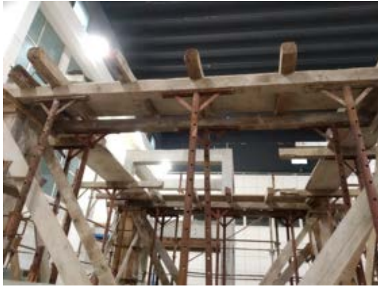
Figura 239. Realizzazione dei pilastri e del solaio: vista dei casseri della trave in spessore
