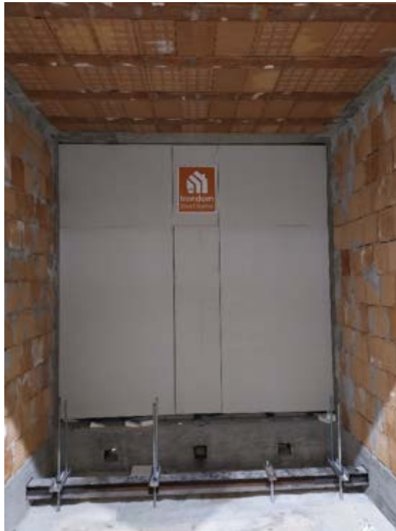
Figura 273. Vista dal lato aperto (sud) della tamponatura a secco IRONDON
