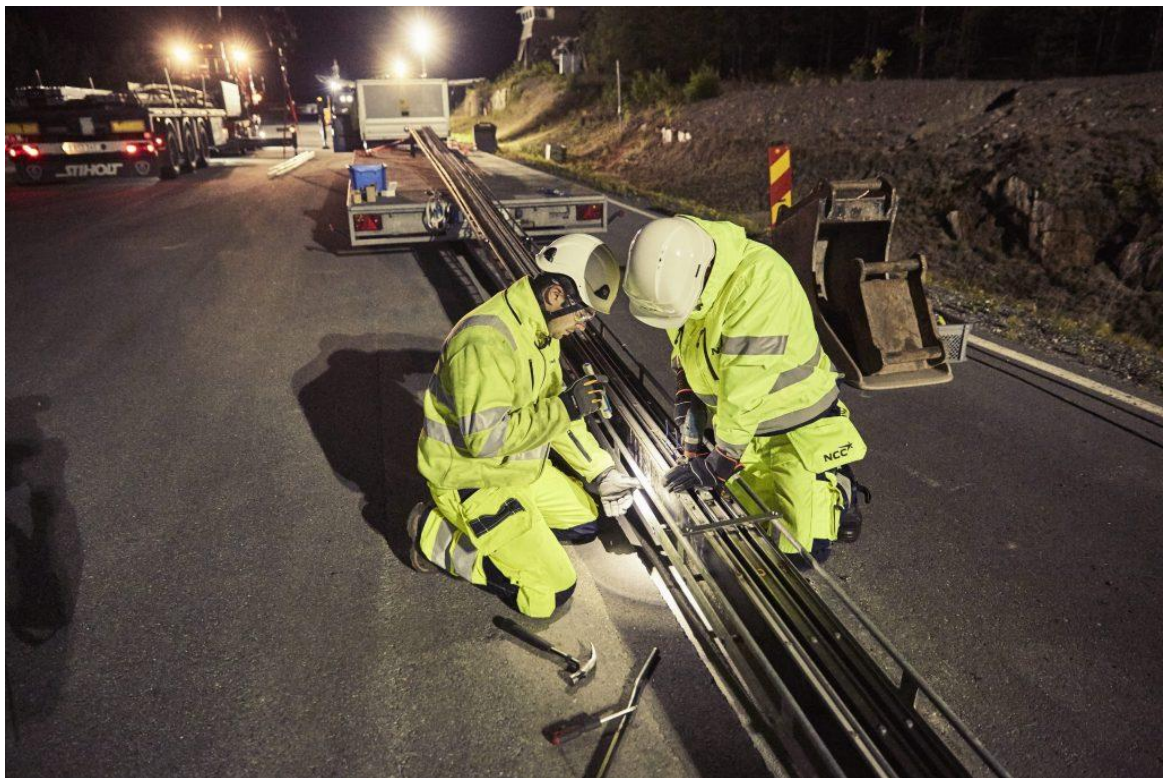
Figura 3. La posa in opera della rotaia elettrica nel sito di eRoadArlanda
