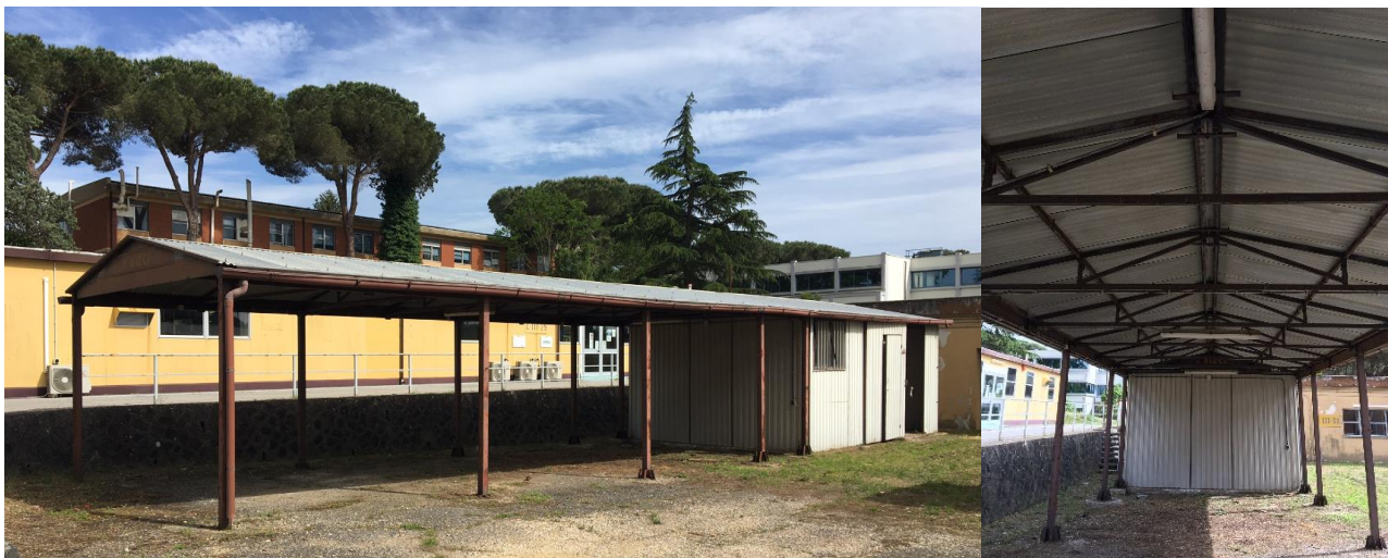
Figura 59. Infrastruttura per installazione impianto evaporativo
