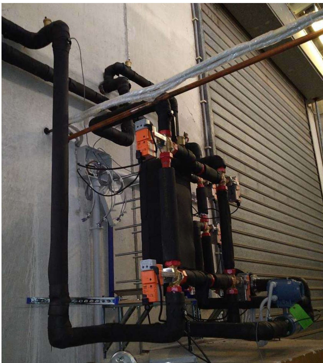
Figura 139 – Impianto coibentato al termine dell'installazione
