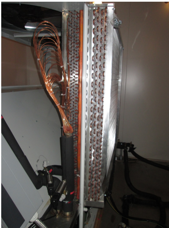
Figura 8 – Doppia batteria alettata gas-cooler / evaporatore
