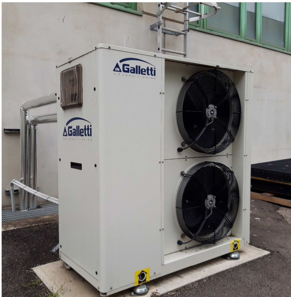
Figura 4. Chiller esterno avente una potenza frigorifera nominale di 18.2 kW.
