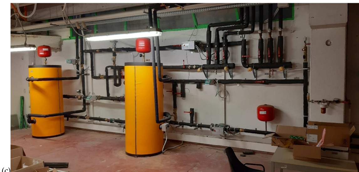
Figura 3. a) Aerotermi interni alla camera climatica; b) sezione di umidificazione ad elettrodi immersi; c) circuito idronico a servizio della camera climatica.
