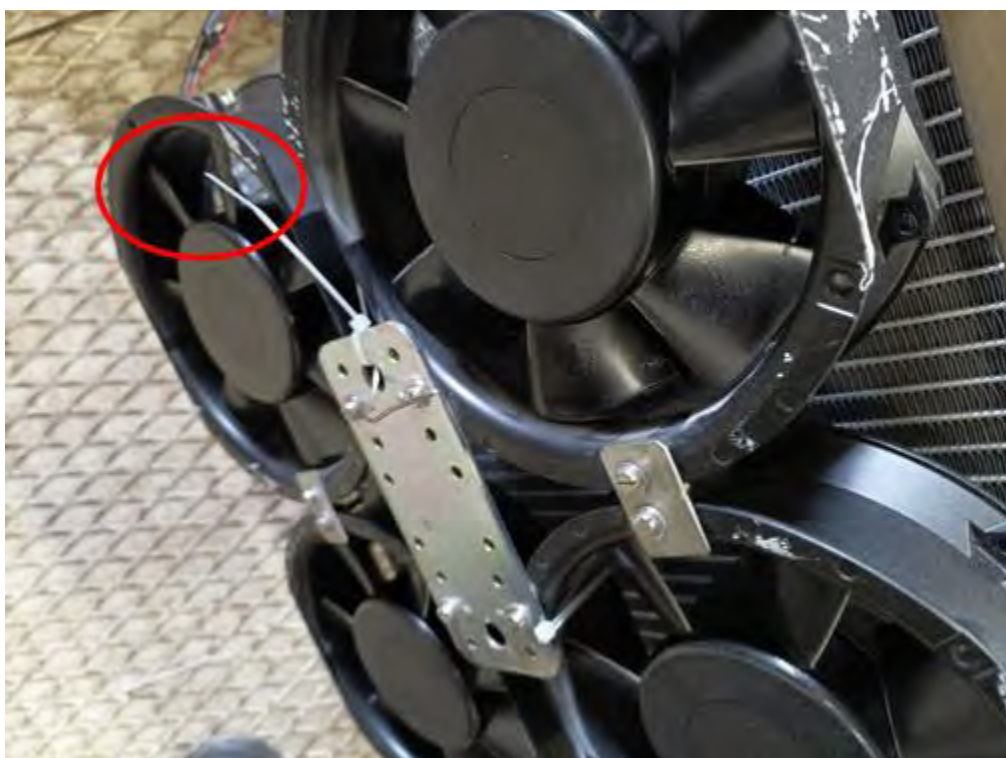
Figura 56. Particolare del posizionamento di una termocoppia
