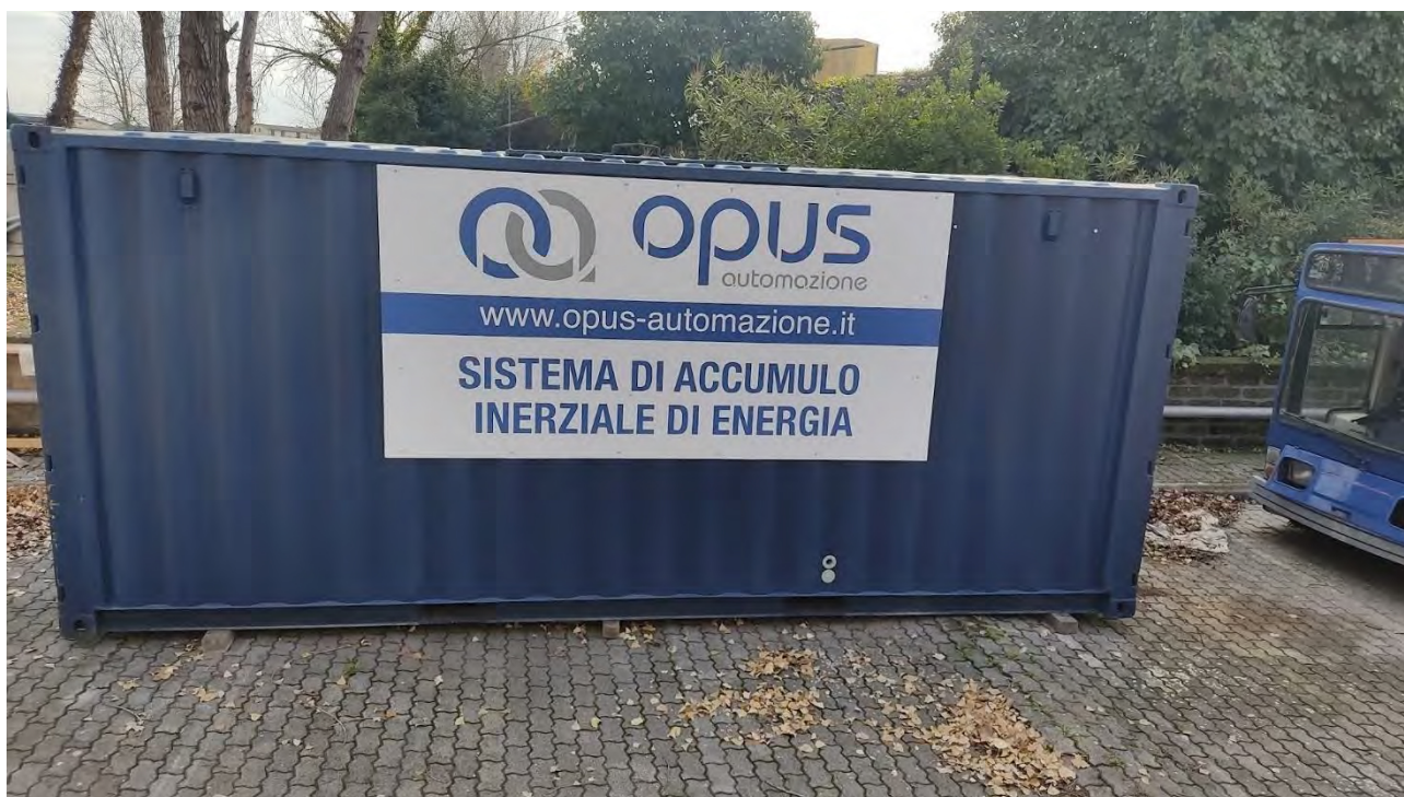
Figura 25: il container realizzato contenente tutti i componenti
