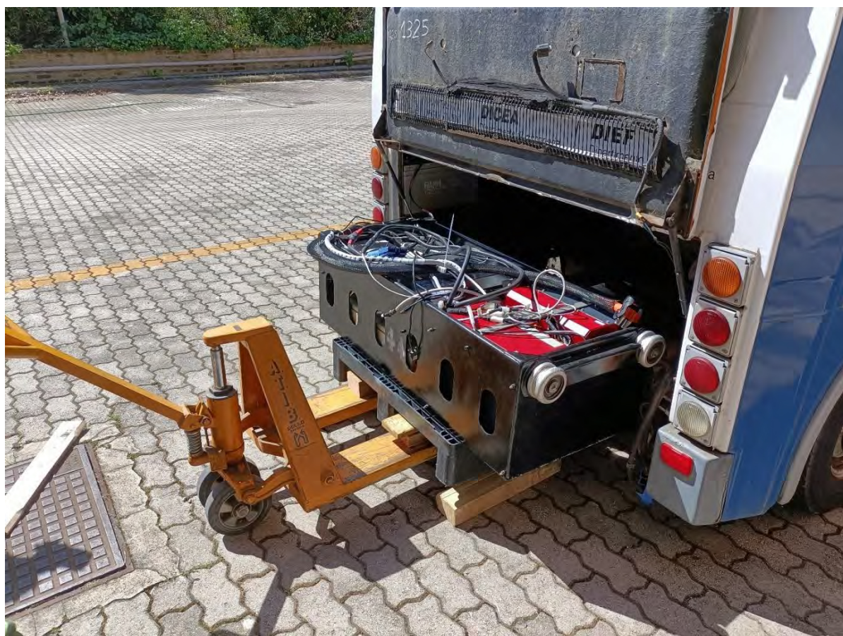
Figura 33. Attività di inserimento del primo contenitore nel vano dedicato sul veicolo.
