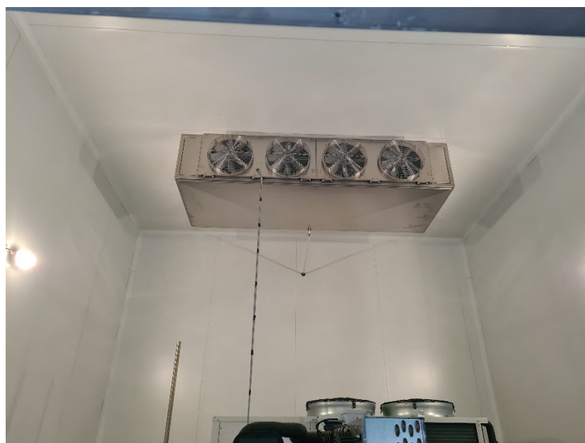
Figura 3: Unità di condizionamento interna alla camera climatica.
