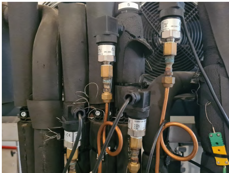
Figura 22: Esempio installazione termocoppie e sensori di pressione
