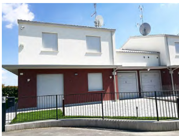
Figura 6. Vista frontale dell'edificio
