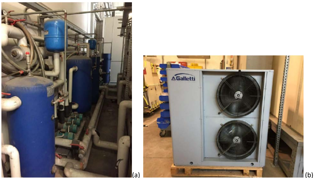
Figura 7. Impianto di condizionamento del calorimetro (a) e chiller al servizio dello stesso (b)
