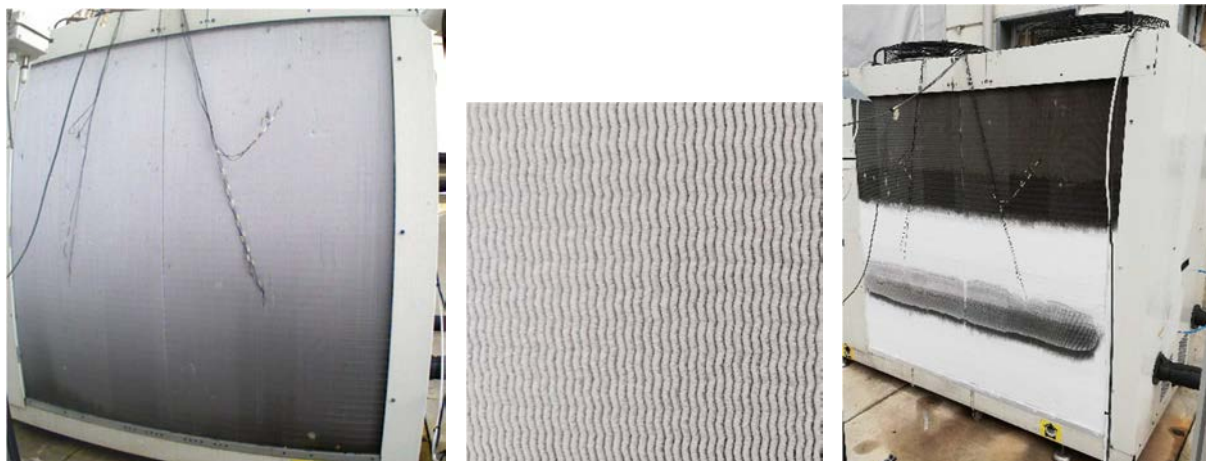
Figura 1. Esempi di batterie alettate di pompe di calore ad aria ricoperte di brina
