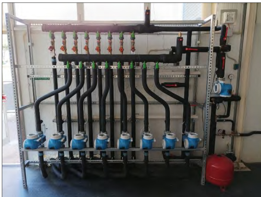
Figura 39. Collegamento delle sonde geotermiche ai due collettori e sensori di controllo
