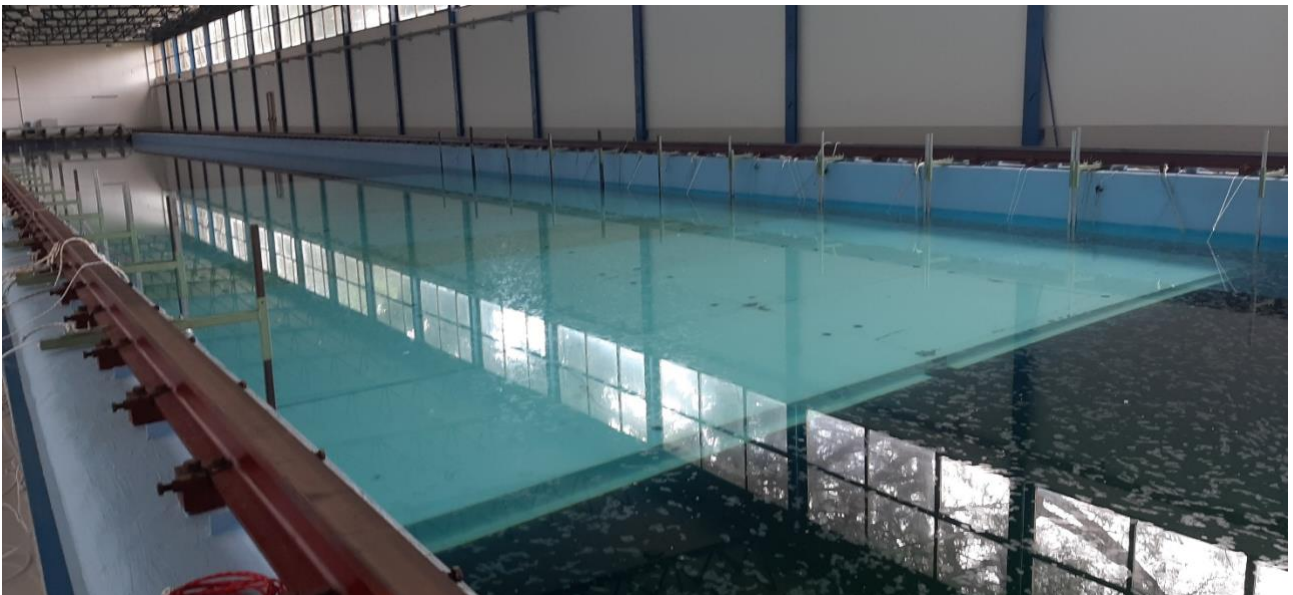
FIGURA 13 FONDALE ARTIFICIALE INSTALLATO. SI EVIDENZIANO I COLLEGAMENTI ALLA STRUTTURA DELLA VASCA.
