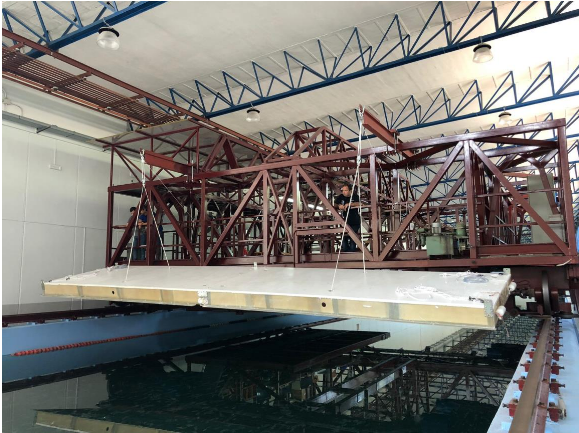
FIGURA 12 INSTALLAZIONE DI UN PANNELLO DEL FONDALE ARTIFICIALE.
