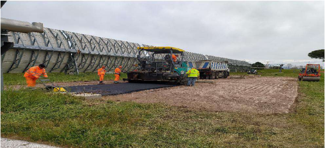
Figura 10. Una fase delle operazioni di stesura del massetto asfaltato
