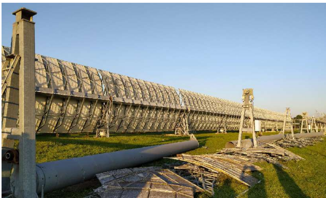
Figura 9. Una fase delle operazioni di dis-assemblaggio del dell'ex collettore solare
