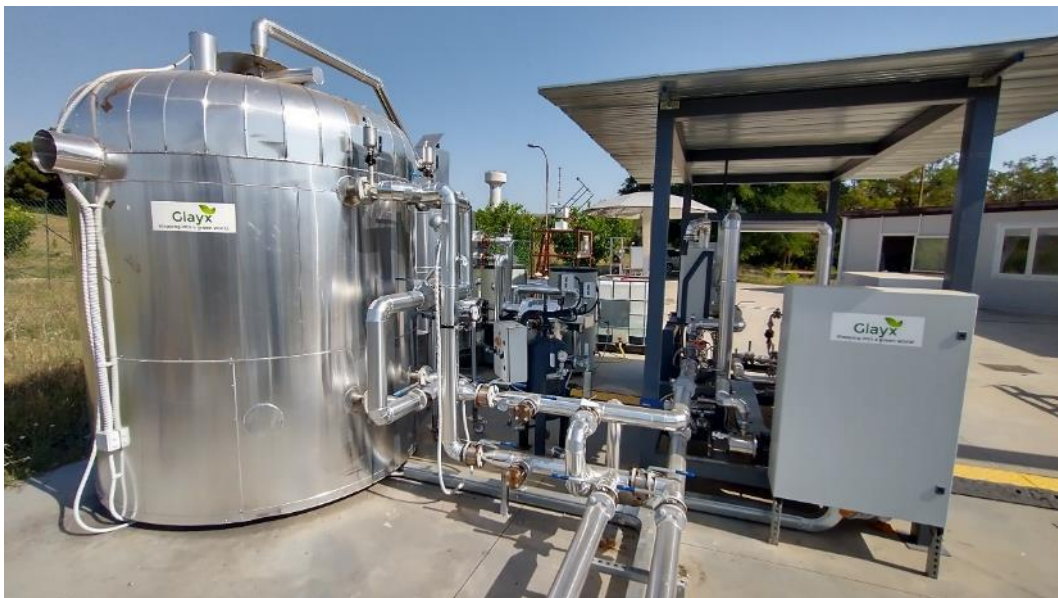
Figura 4 - Foto del circuito HTF che connette i tre macro-componenti della facility di test
