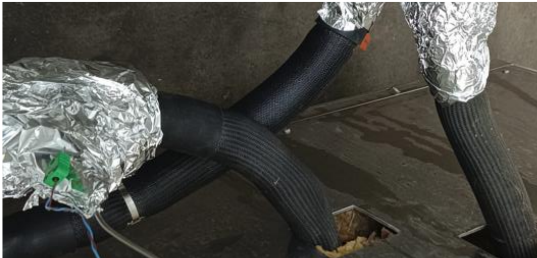
Figura 7-3: Tubi flessibili da impiegare per l'accoppiamento in serie dei due moduli di accumulo termico.
