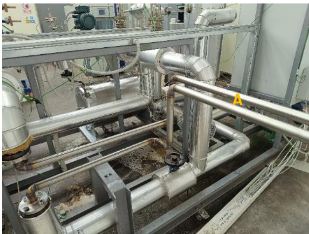
Figura 8: installazione nuove linee olio dall'impianto (a) verso il nuovo aerotermo esterno (b)
