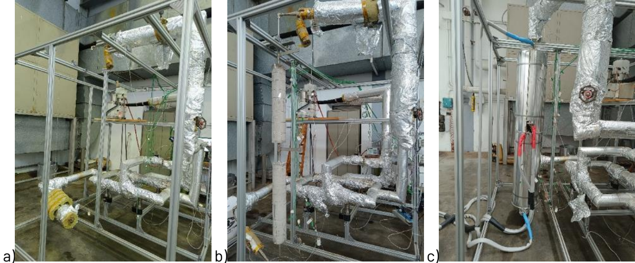
Figura 2: Impianto ATES: a) aggiornato pronto per accogliere la sezione di prova, b) con la sezione di prova non coibentata e c) con la sezione di prova coibentata.
