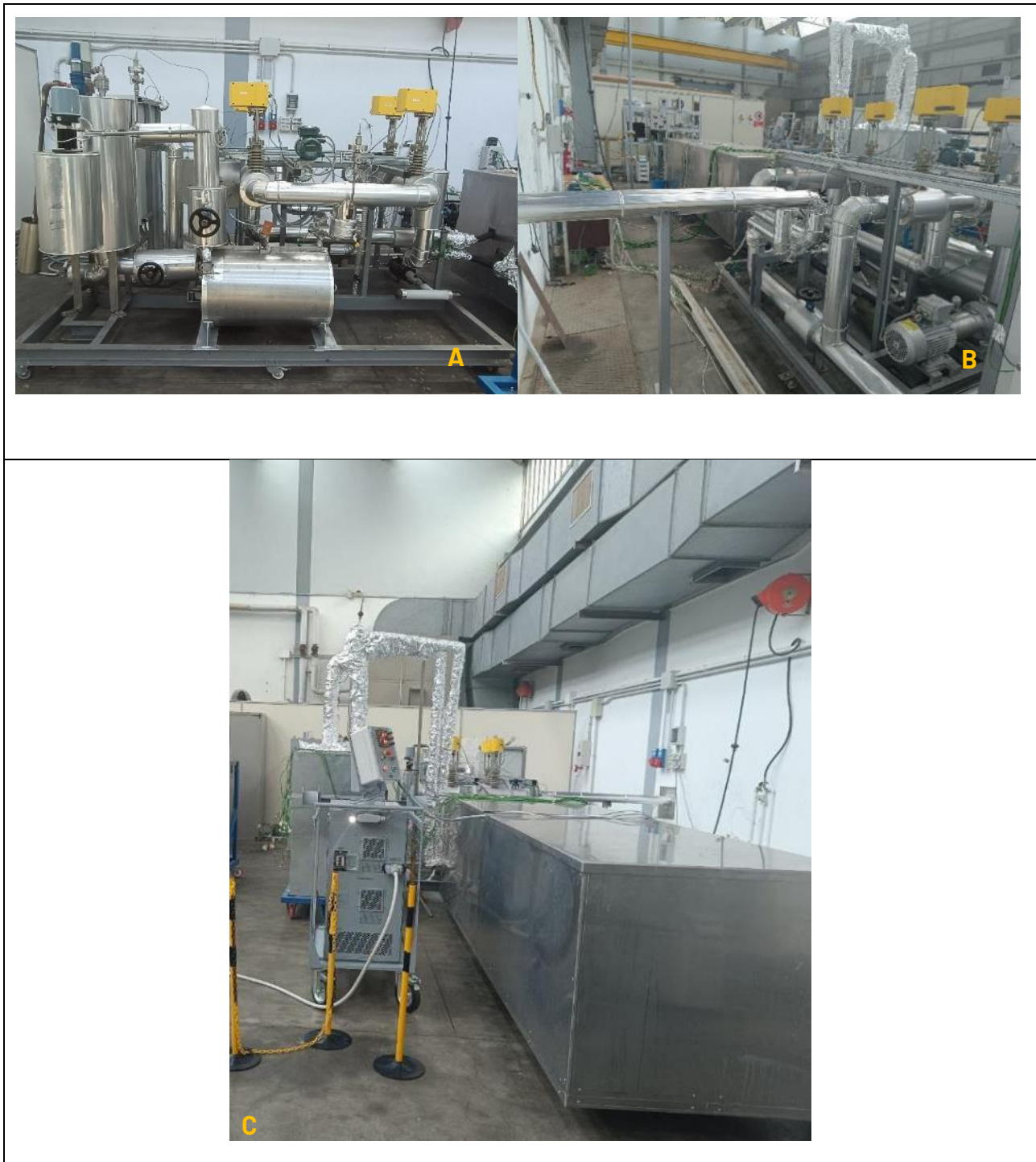
Figura 9: impianto Solteca3 dopo installazione nuovi componenti (A: fronte; B: retro; C: accoppiato al modulo cementizio e a quello a cambiamento di fase, sulla sinistra è visibile anche l'alimentatore per il riscaldamento dello scambiatore ad olio tramite effetto Joule e a destra è in evidenza il modulo cementizio).
