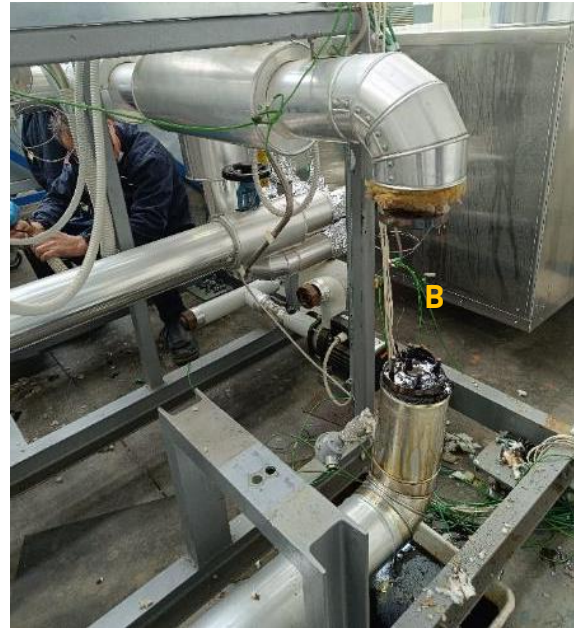
Figura 7: rimozione del circuito di riscaldamento (a) e raffreddamento (b)
