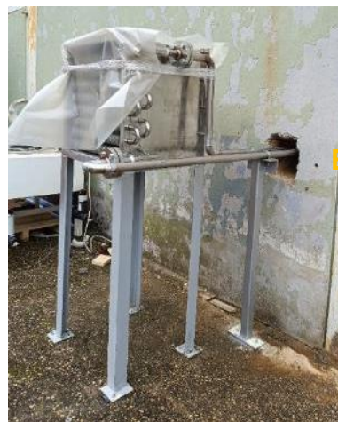
Figura 8: installazione nuove linee olio dall'impianto (a) verso il nuovo aerotermo esterno (b)
