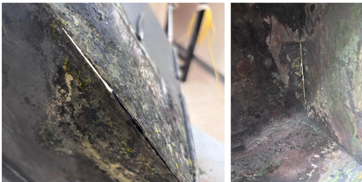
Figura 28 – Foto che evidenziano la fessurazione della storta a seguito di corrosione
