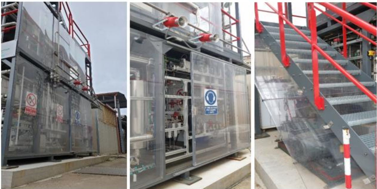
Figura 7.2 - Installazione della pannellatura laterale fissa e mobile (in alto) e coperture sia in policarbonato che lamiera zincata (in basso).
