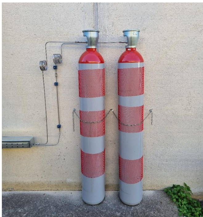
Figura 5.14 - Vista frontale dei buffer V-001 e V-002.
