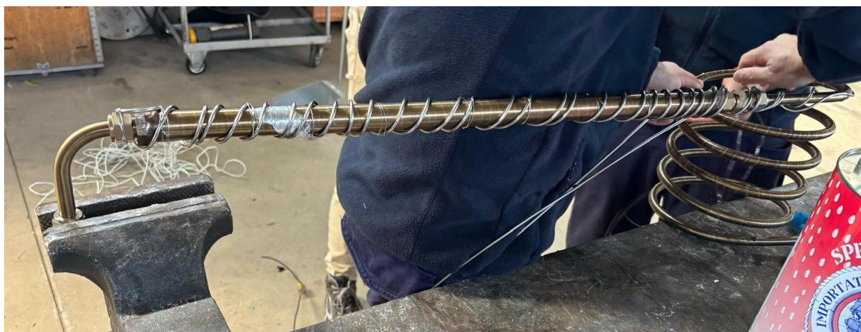
Figura 4.10 - Fase di installazione del cavo scaldante ad isolamento minerale della lunghezza di 6 metri sul tubo dritto.
