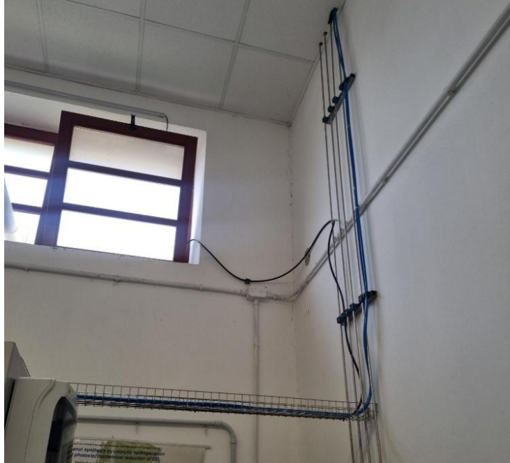
Figura 5.23 - Vista della linea per il trasporto dell'acqua di rete (tubi blu) in ingresso e in uscita dal cabine .
