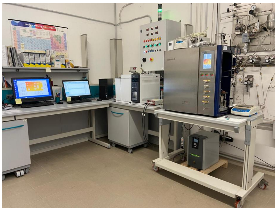
Figura 3.1 - Impianto bench-scale XTL installato presso i laboratori Sotacarbo.
