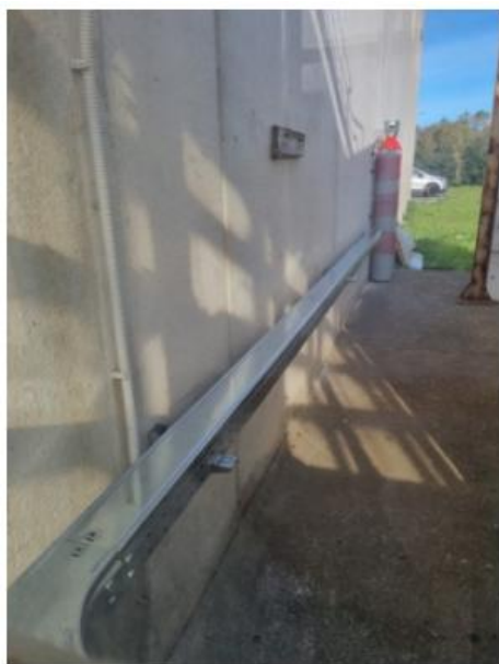
Figura 5.22 - Vista della canalina zincata fissata alle pareti, attraverso cui transitano le linee di distribuzione dell'idrogeno, dal cabinet al sistema di stoccaggio e viceversa.
