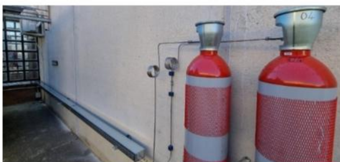
Figura 5.22 - Vista della canalina zincata fissata alle pareti, attraverso cui transitano le linee di distribuzione dell'idrogeno, dal cabinet al sistema di stoccaggio e viceversa.
