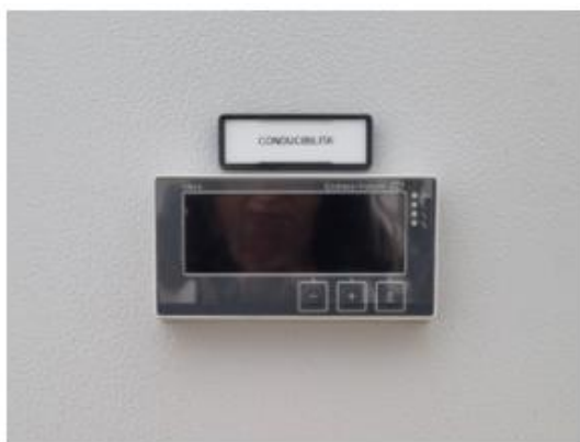
Figura 5.16 - Vista frontale della centralina di misura della conducibilità dell'acqua, a sinistra, e sonda di misura dell'acqua (CM-001).
