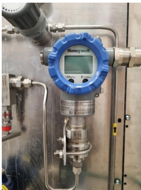
Figura 5.17 - Vista di un trasmettitore di pressione con manometro digitale integrato (PIT-001).
