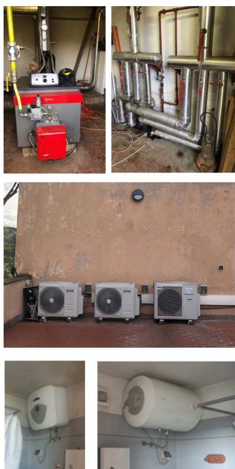
Figura 7. Esempio di Quadro di sintesi con le caratteristiche dei principali sistemi di generazione per i servizi di riscaldamento, raffrescamento e acqua calda sanitaria nel complesso di Villa dei Quintili.
