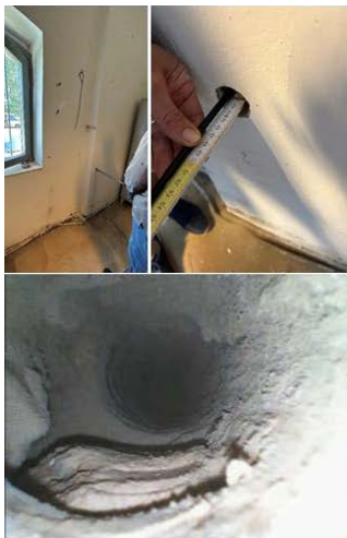
Figura 5. Esempio di caratterizzazione di una delle murature di Villa di Sette Bassi con documentazione fotografica della video-ispezione effettuata.
