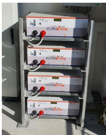
Figura 11: Supercondensatori installati su struttura di tipo rack all'interno della cabina 3
