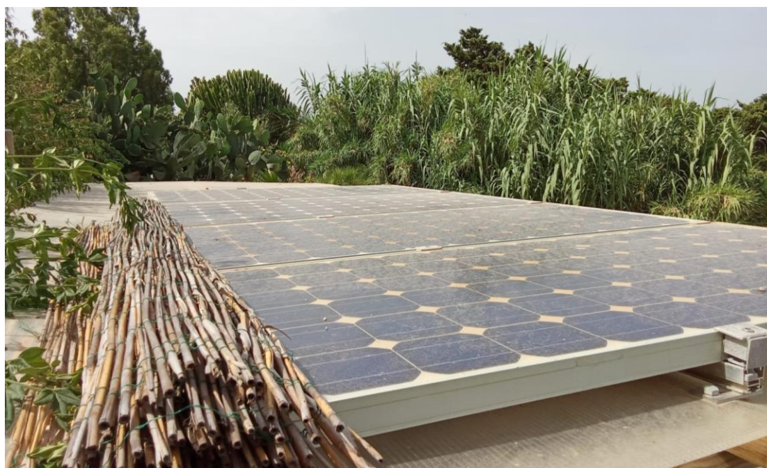
Figura 7. Impianto solare fotovoltaico di recupero installato presso l'impianto sperimentale de i Nuovi Mille per il riscaldamento dei biodigestori
