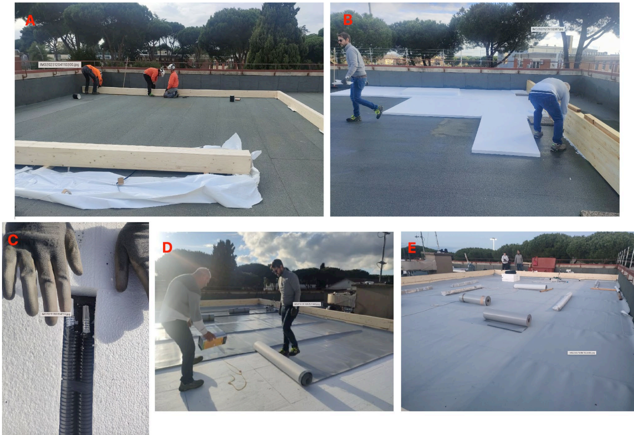
Figura 10. Fotografie sul tetto durante il cantiere per l'installazione del sistema BGR. A) Posa in opera delle travi a costituire il profilo di contenimento per delimitare la superficie del campo prova; B) posa in opera dei pannelli pendenzati; C) particolare del posizionamento della coppia di sensori di contatto per la misura della temperatura superficiale del lastrico solare, sotto manto, a livello della parcella P4; D) e E) posa in opera della guaina.
