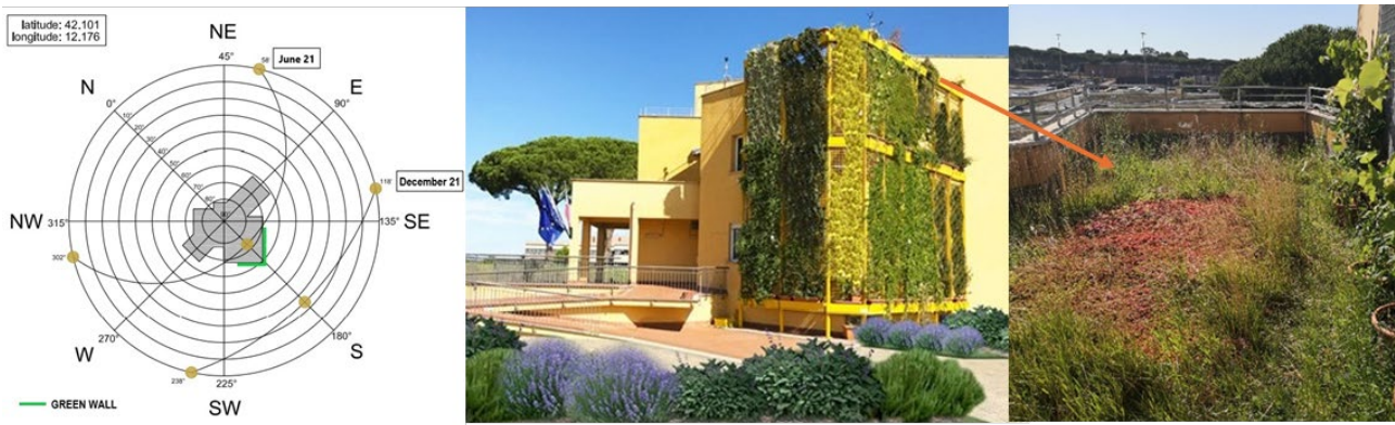
Figura 13 – Edificio F92 C.R. ENEA Casaccia, Roma. A) Rappresentazione dell'orientamento dell'edificio F92 rispetto ai punti cardinali. I lati a Sud Est e Sud Ovest, evidenziati in verde, sono quelli interessati dalla presenza della parete e del tetto verde. B) Vista dell'edificio F92 dal lato Sud, C) Particolare della porzione di Tetto Verde a Sedum
