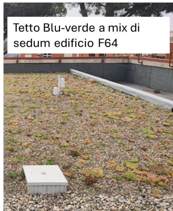
Figura 18. In alto sono riportate le differenze tra gli andamenti giornalieri della temperatura superficiale tra il lastrico solare vegetato e non vegetato nei due edifici. In basso è illustrata la copertura a Sedum sul Tetto verde dell'edificio F92 (a sinistra) e sul Tetto Blue-Green dell'edificio F64 (a destra). Periodo dal 12 al 15 giugno 2024
