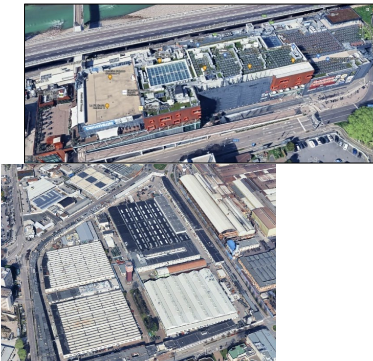
Figura 3 - Tetto verde complesso (estensivo e biosolare su più piani) del centro commerciale Twenty e tetto tradizionale dello stabilimento IVECO
