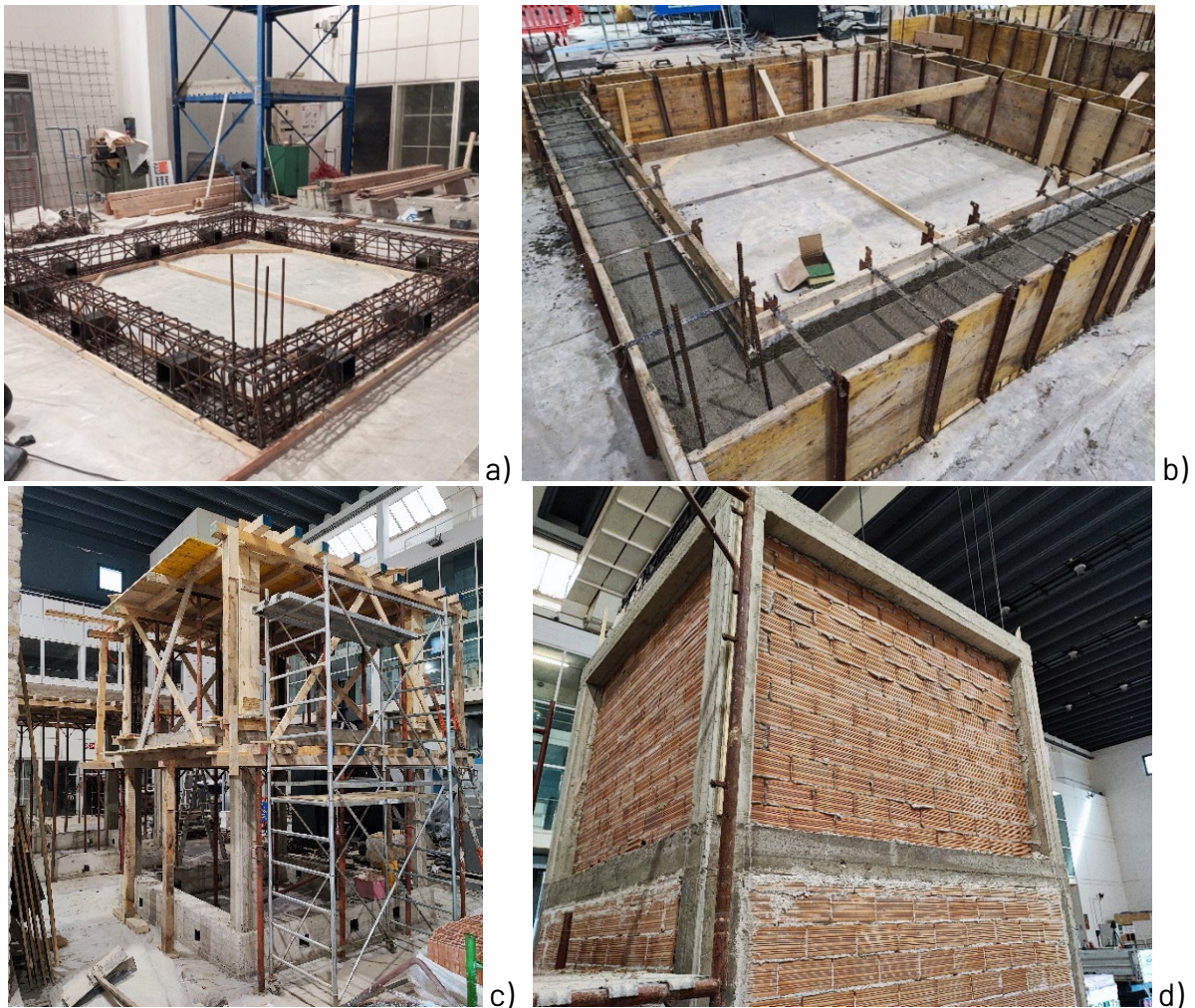
Figura 19. Fasi di costruzione del prototipo in c.a. tamponato a due livelli: realizzazione dell'armatura del cordolo di fondazione (a); maturazione della gettata di calcestruzzo del cordolo di fondazione (b); preparazione delle casseforme per la gettata dei pilastri e del solaio del secondo livello (c); realizzazione della tamponatura (d).
