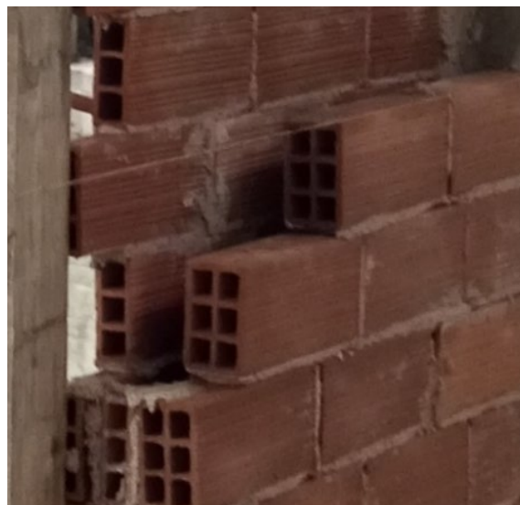
Figura 19. Fasi di costruzione del prototipo in c.a. tamponato a due livelli: realizzazione dell'armatura del cordolo di fondazione (a); maturazione della gettata di calcestruzzo del cordolo di fondazione (b); preparazione delle casseforme per la gettata dei pilastri e del solaio del secondo livello (c); realizzazione della tamponatura (d).
