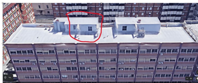
Figura 45 - Prospetto Ovest parete di test
