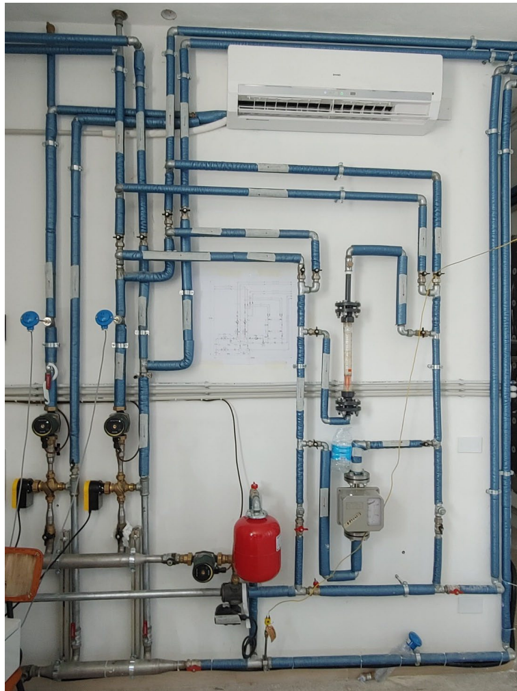
Figura 69 - Distribuzione impianto termico
