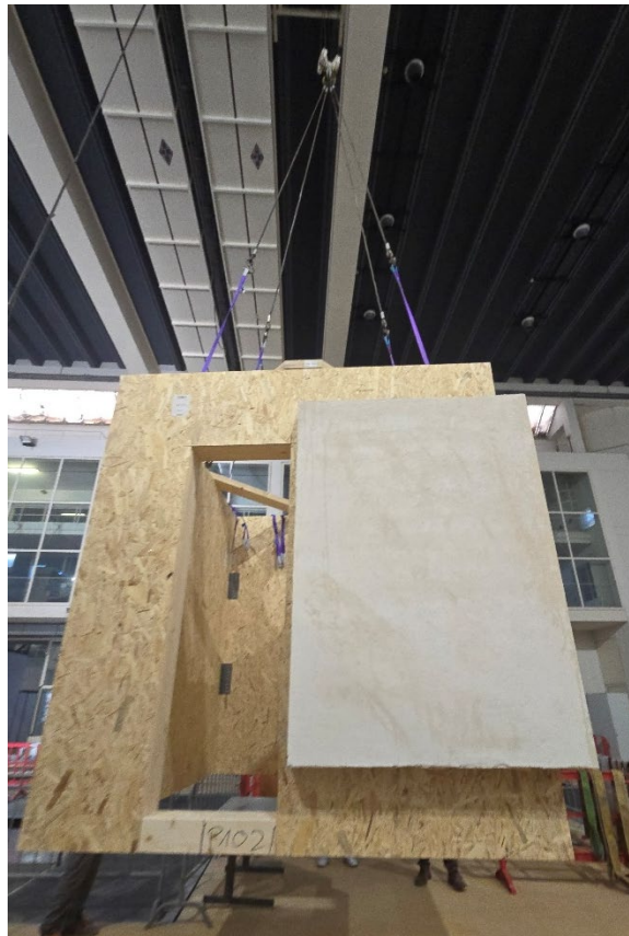
Figura 29 - Spostamento del blocco prefabbricato direttamente da camion a tavola vibrante
