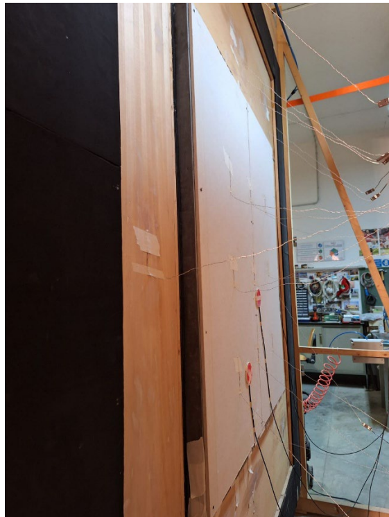
Figura 54 - Vista del campione con sistemi di accumulo lato camera calda dopo l'inserimento dell'isolante e la chiusura finale in cartongesso
