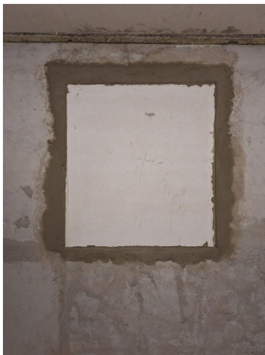
Figura 73 - Vista del campione con sistemi di accumulo, chiusura esterna (camera emittente)
