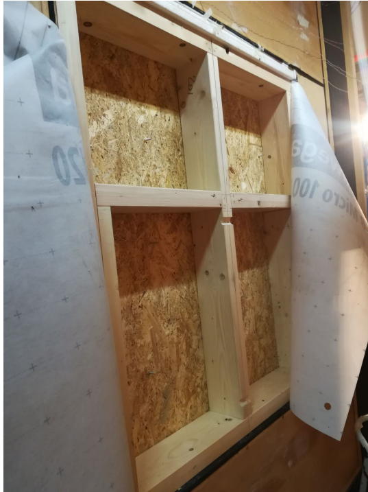
Figura 51 - Vista del campione tradizionale lato camera calda prima dell'inserimento dell'isolante
