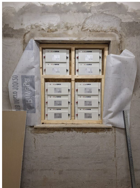
Figura 72 - Vista del campione con sistemi di accumulo, prima della finitura interna (camera ricevente)
