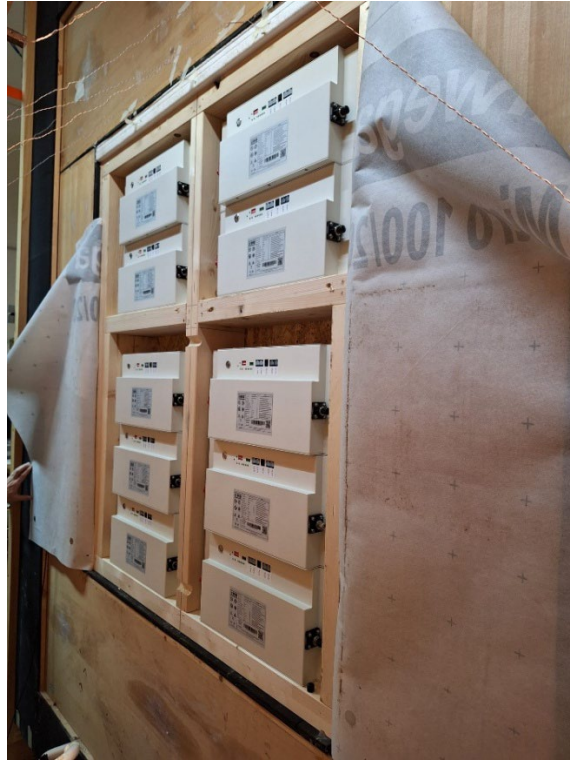
Figura 53 - Vista del campione lato camera calda con l'inserimento dei sistemi di accumulo
