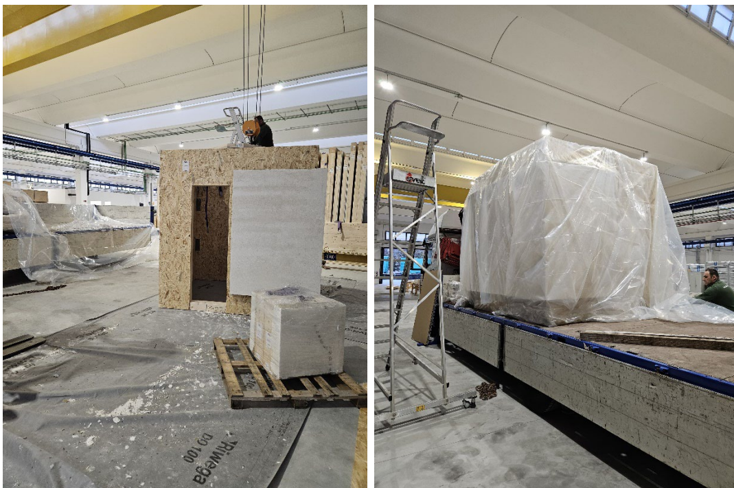
Figura 27 - Assemblaggio del blocco prefabbricato di pareti e caricamento su pianale per il trasporto
