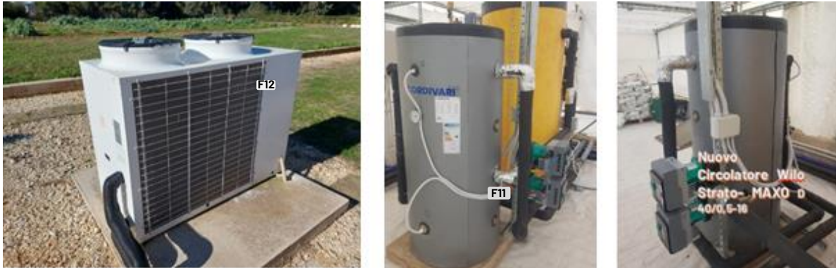
Figura 10- Installazione nuovo serbatoio inerziale da 500 litri - foto impianto
