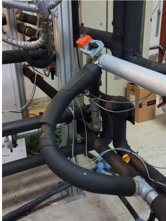
Figura 3. By-pass con valvola a 3 vie.
