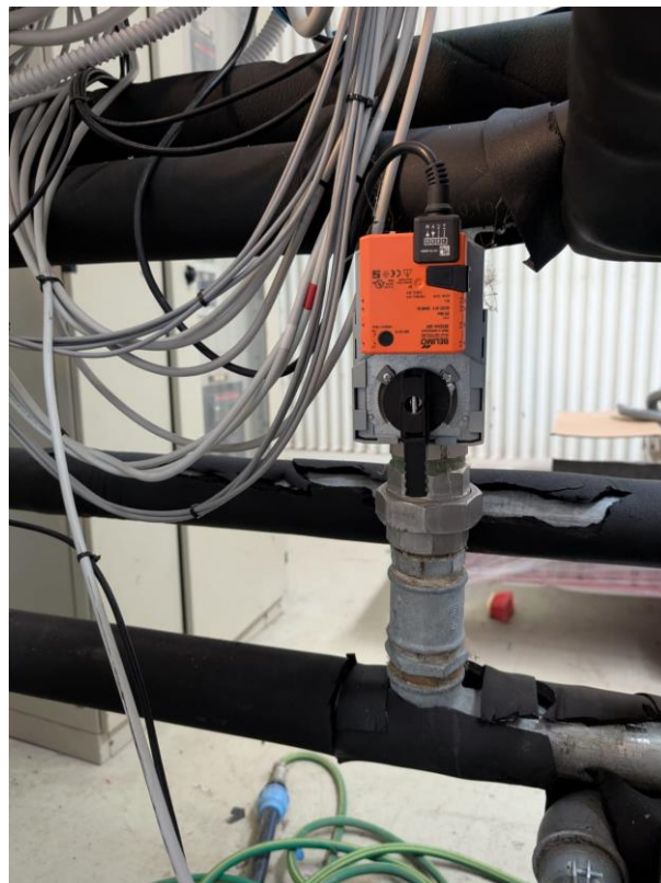
Figura 10. By-pass nel caso di impianto in modalità invernale.
