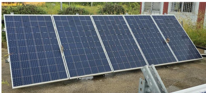
Figura 4. Immagine d'insieme di una parte pannelli installati
