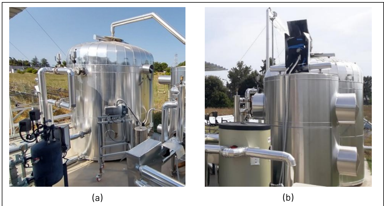
Figura 6 – Foto del reattore a zeoliti (a) e del phase-changer (b)
