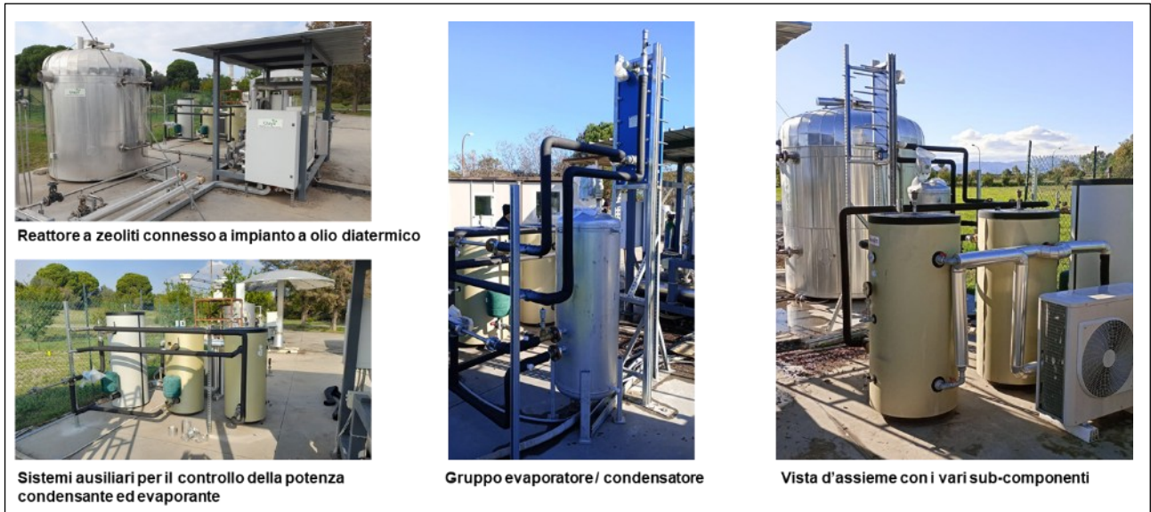
Figura 20 - Up-grade facility Sunstore - fase realizzativa
