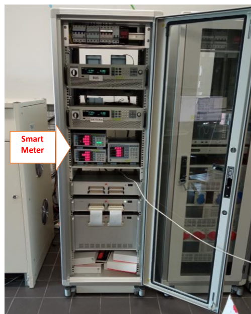
Figura 4: alcuni dei misuratori monofase e trifase utilizzati
