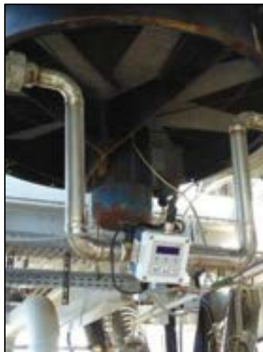
Figura 27. Misuratore di portata condense ad ultrasuoni
