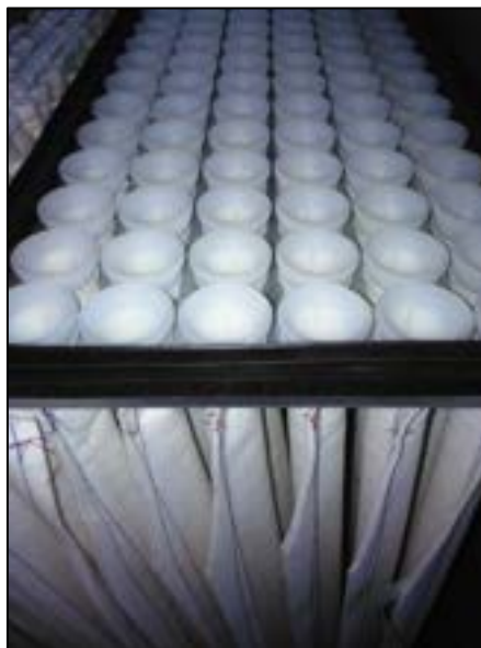
Figura 20. Dettaglio dei cassettei filtranti
