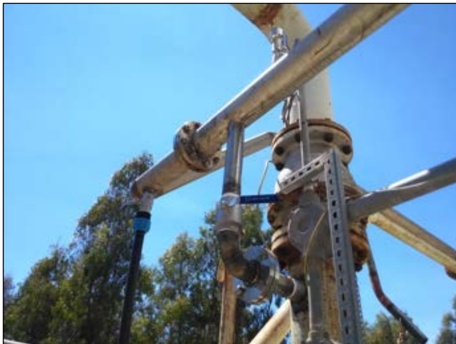
Figura 42. Punto di immissione dell'azoto per l'inertizzazione della linea.
