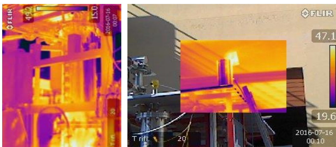
Figura 14. Immagine termografica con dettaglio di gassificatore e torcia
