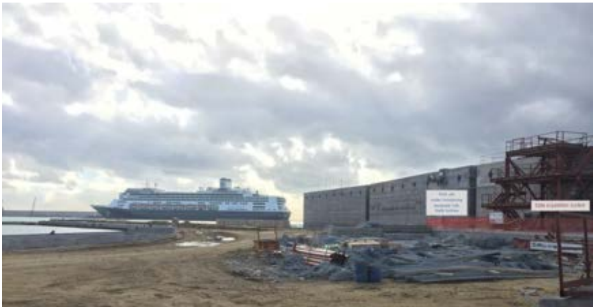
Figura 32. Sistema di acquisizione operativo a Civitavecchia: due celle attive monitorate mediante sensori di misura su due celle adiacenti, una con turbina e una con sfiato, e collegate ad una stazione di acquisizione dati.
