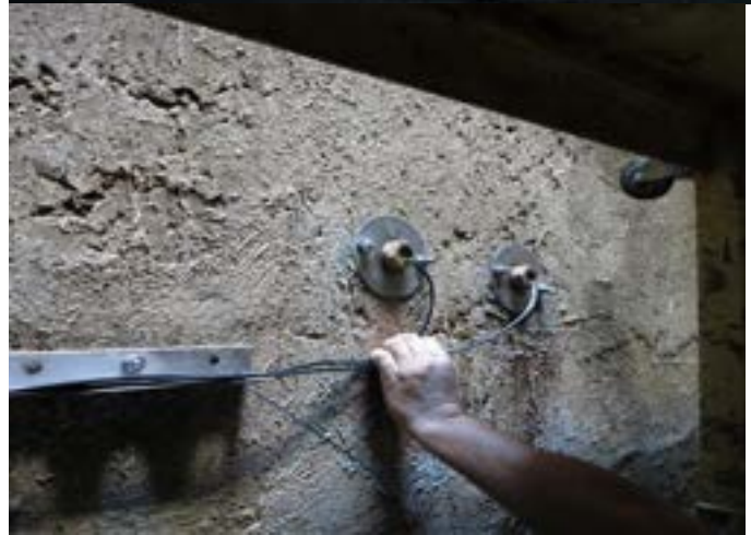
Figure 31. Alcune immagini durante la fase di installazione dei trasduttori nelle celle di assorbimento.
