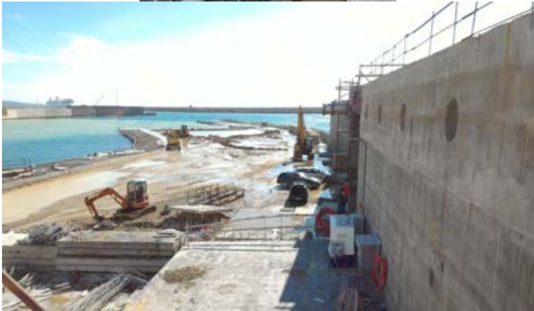
Figura 29. Fasi di installazione della turbina di Wells.
