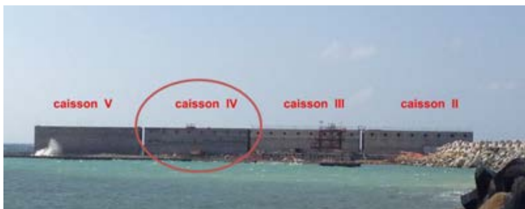
Figura 28. Vista del cassone in cui due celle adiacenti sono attualmente strumentate per il monitoraggio. Nella cella più a Nord confinate con il cassone III è posizionata la turbina, in quella adiacente è operativa la strumentazione con sfiato da 0.45m.
