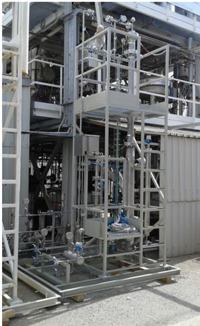
Figura 5. Posizionamento della colonna di assorbimento della CO 2
