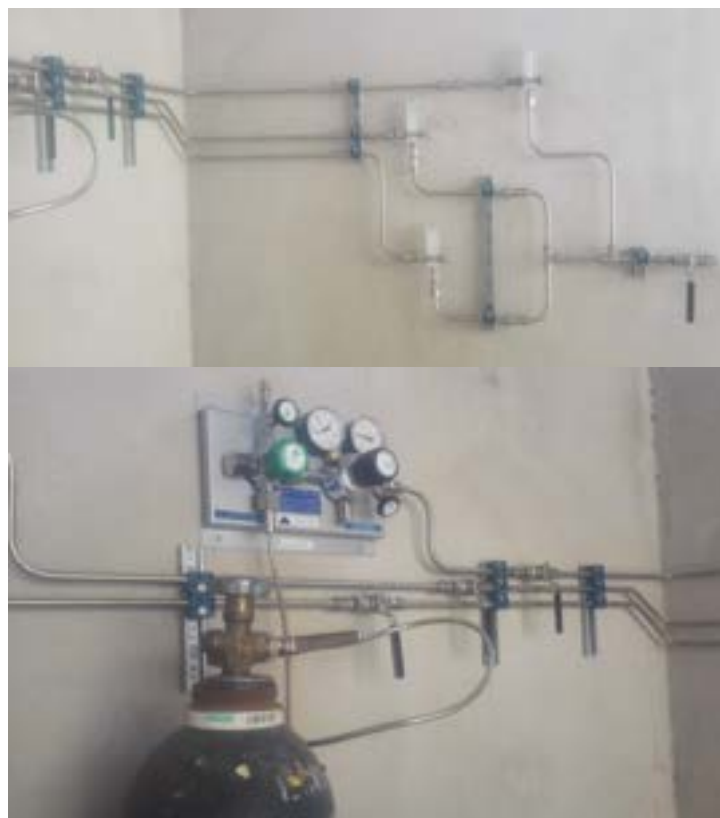
Fig.3.2. Linee di distribuzione gas e stadio di decompressione
