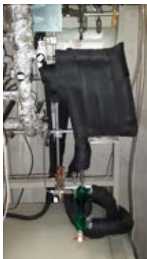
Figura 1.11. Zona di preraffreddamento e trappola di condensazione
