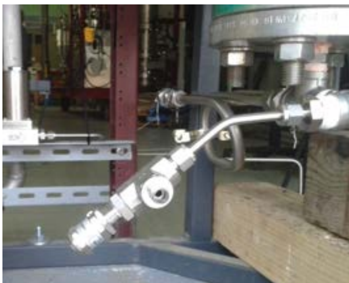
Figura 8. Valvola relief di sicurezza
