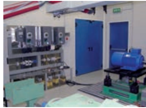
Vista di insieme del prototipo costruito presso l'ENEA
