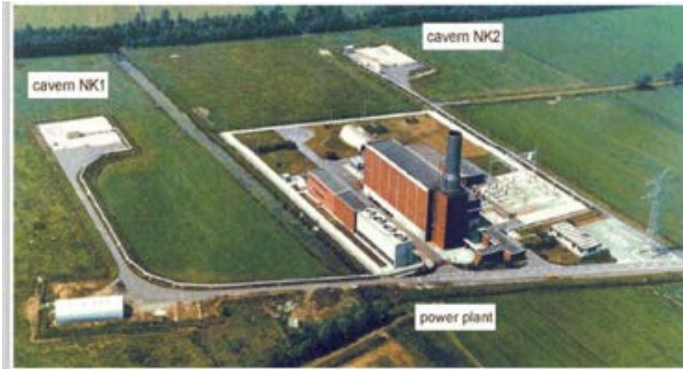
Impianto CAES di Huntorf (Germania)
